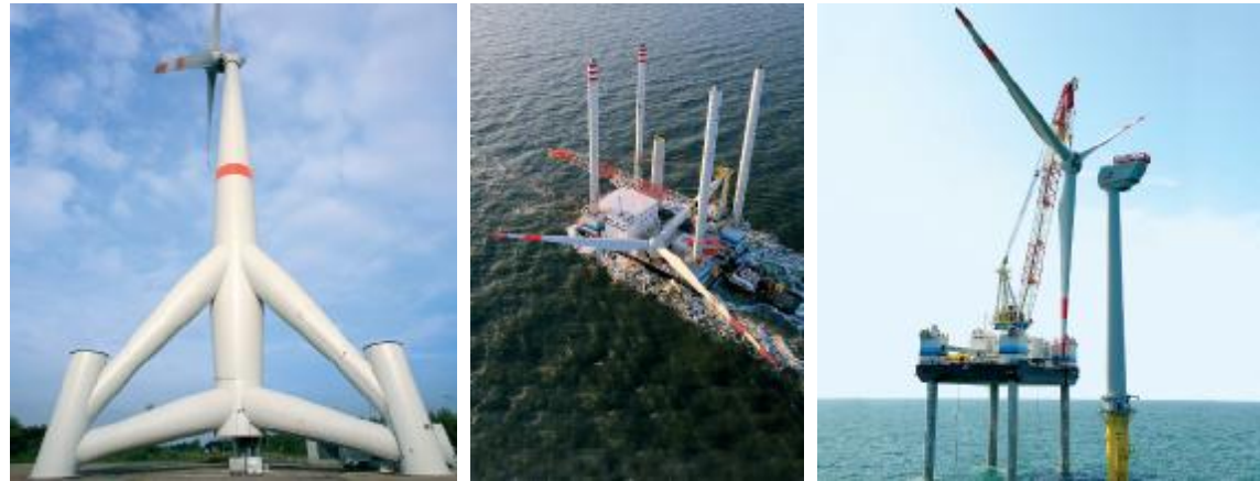
Offshore-Windpark alpha ventus in der Nordsee
